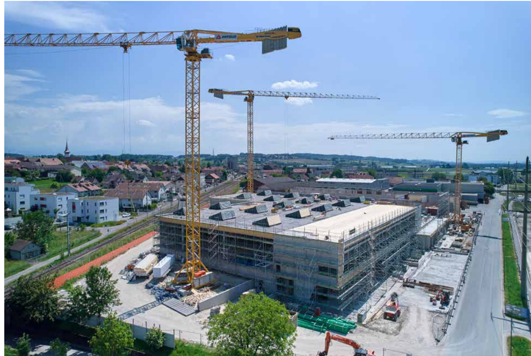
La réalisation du nouveau bâtiment d'exploitation de Terraviva ag/sa est en bonne voie à mi-parcours de la période de construction.
